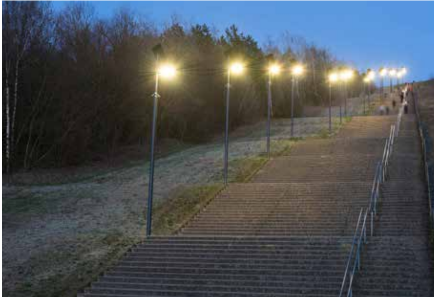
protos Treppe Wilhelmberg / NL
